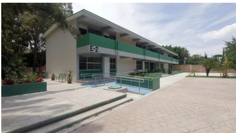
CONALEP Plantel 133 CCT 12DPT0008I Chilapa de Álvarez, Guerrero.
